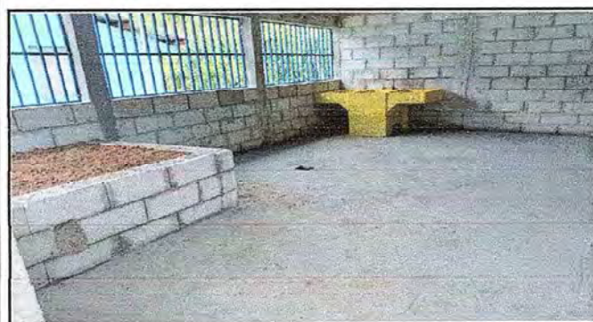
Foto 5: Proceso de colocación de piso en cocina.
