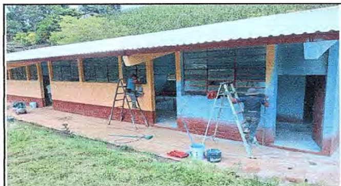
Foto 3: Pintado de paredes del edificio educativo.
