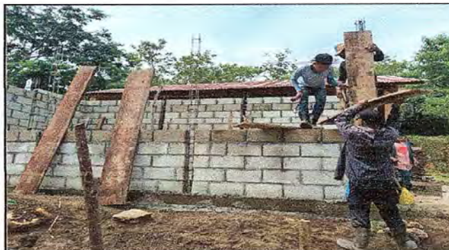
Foto 4: Sustitución de las paredes de cocina.
